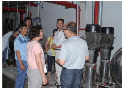
□ 二次供水管理中心人员进行设备检修
