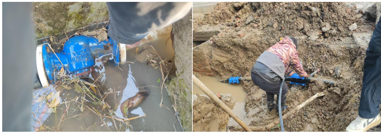
图 3-5 武墩街道现状供水管道维修现状
