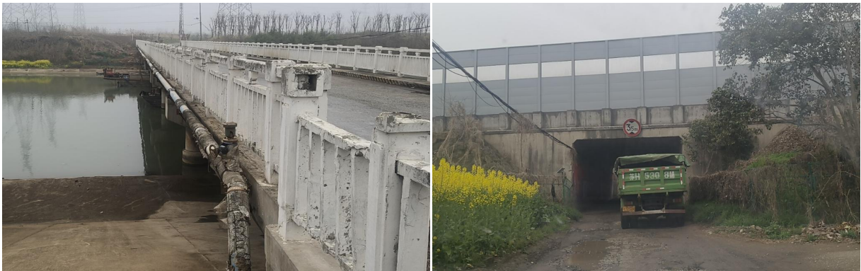
图 4-5 城南街道跨河跨路段现状图
