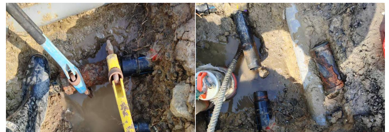
图 3-9 和平镇现状供水管道维修现状
