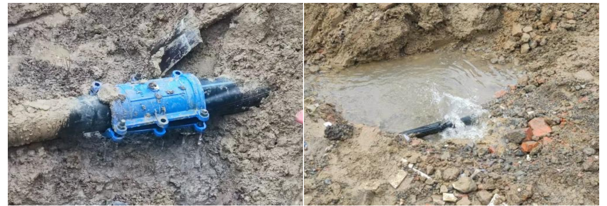
图 3-7 城南街道现状供水管道维修现状
