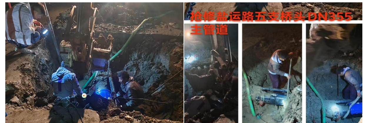
图 3-8 黄码镇现状供水管道维修现状
