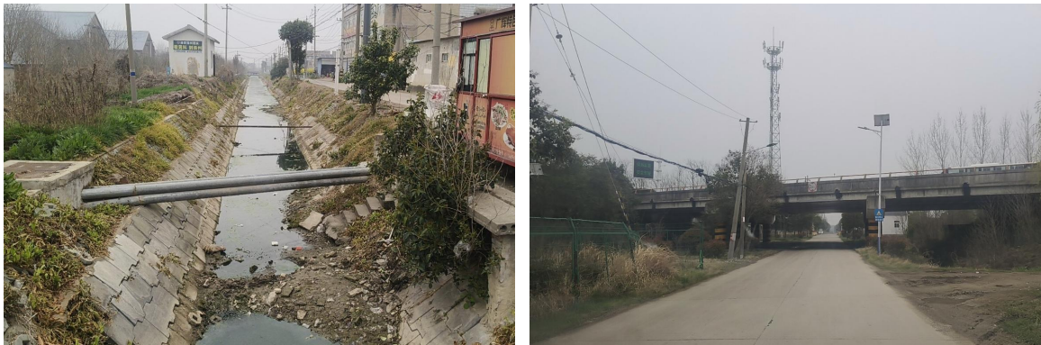
图 4-10 盐河街道跨河跨路段现状图
